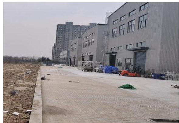
项目西侧-三湾工业·高陵科技创新谷工业园 （建设中）
