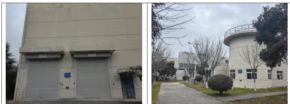
污水处理设施
