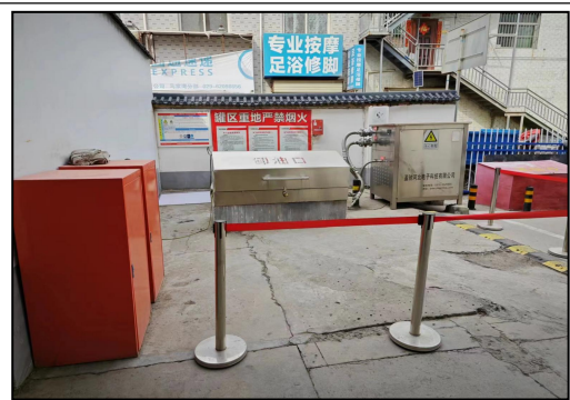
三次油气回收装置及卸油口
