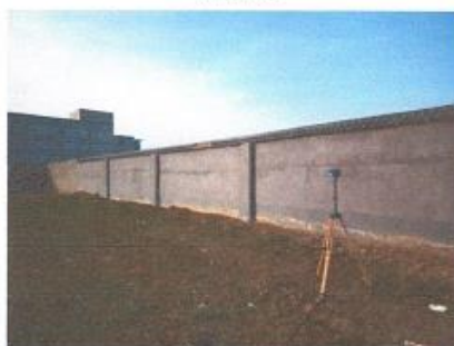
拟建月工 110kV 变电站东厂界
