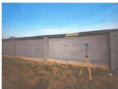
拟建月工 110kV 变电站南厂界
