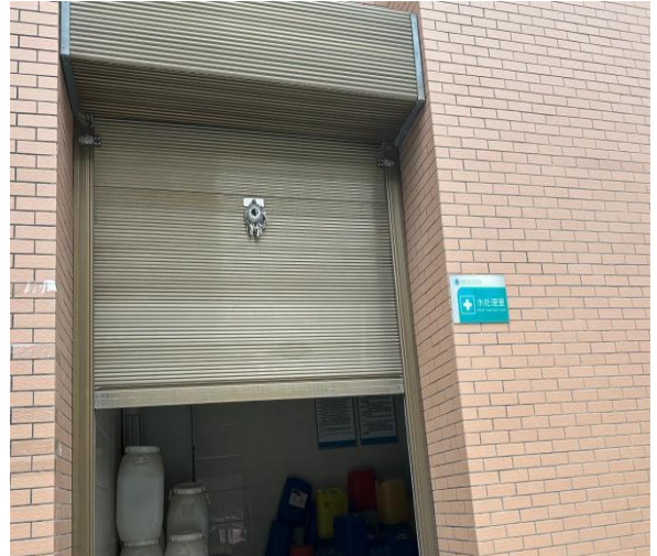
依托工程一医院的水处理室
