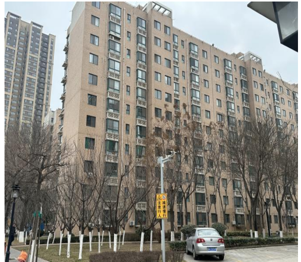
本项目西侧一沁园小区
