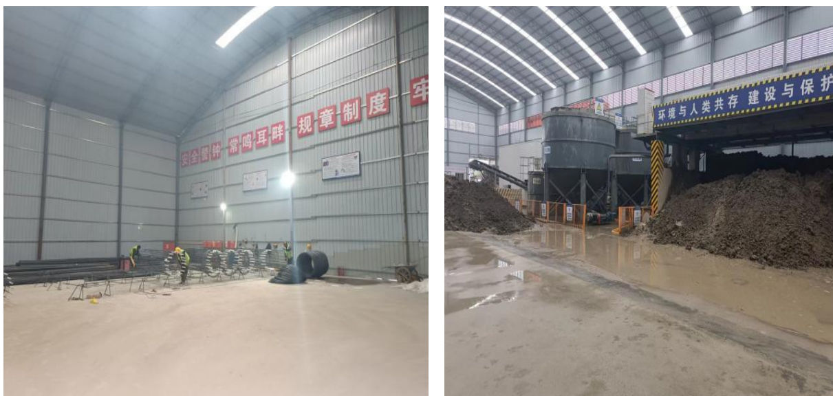
图 6.1-1 降噪棚封闭施工现场照片
