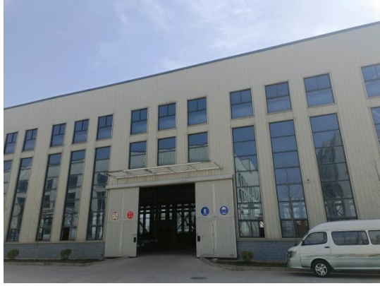
本项目所在车间西侧（3#车间）
