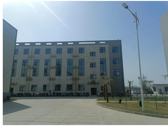
本项目所在车间南侧（生活楼）
