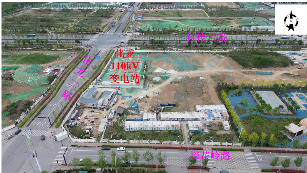
图 2-9 在建化龙 110kV 变电站现状
