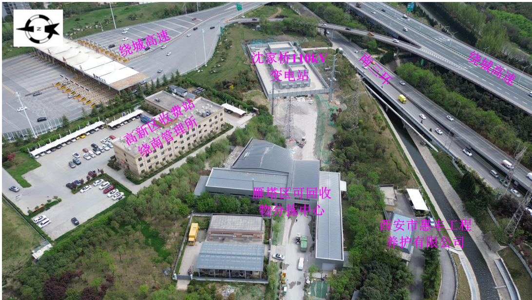
图 2-5 沈家桥 110kV 变电站四邻关系现状照片
