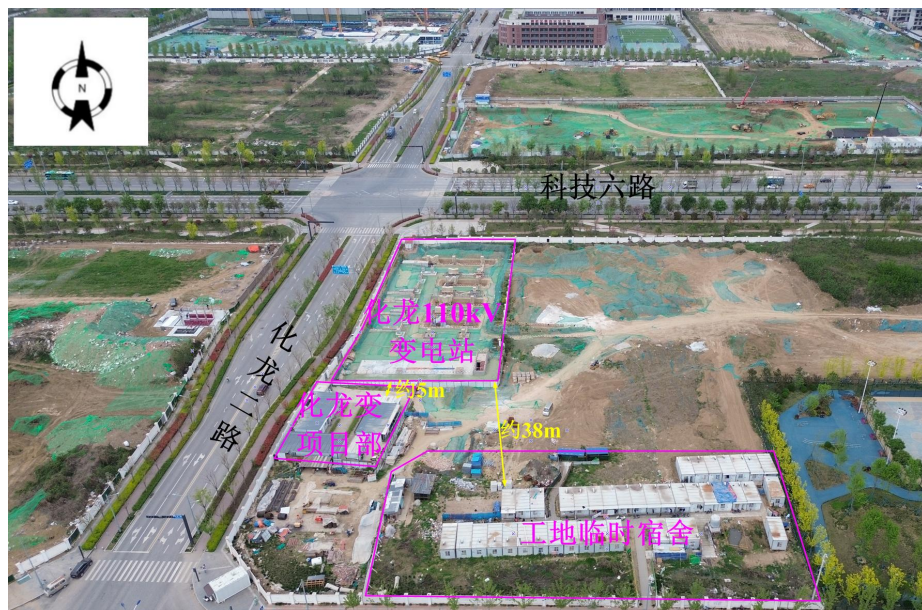
图 3-9 化龙 110kV 变电站环境保护目标航拍图
