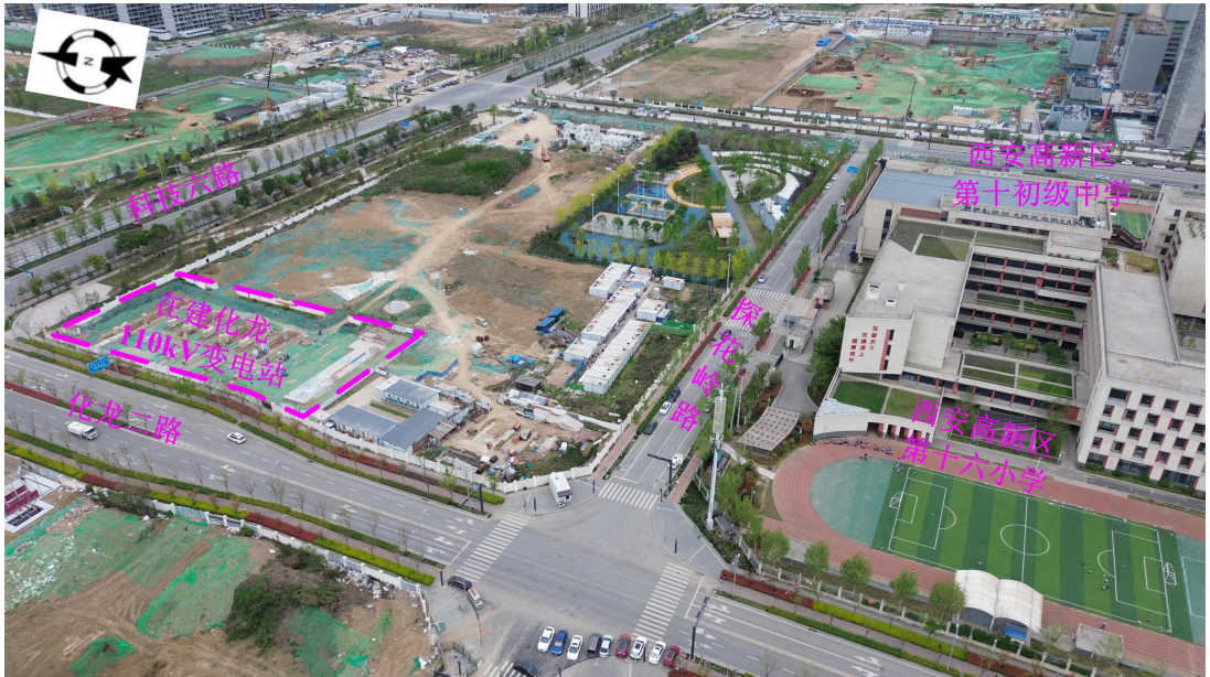
图 2-3 在建化龙 110kV 变电站四邻关系现状照片
