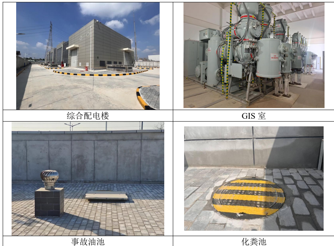
图 2-4 阎航 I 110kV 变电站内部分设施现状
