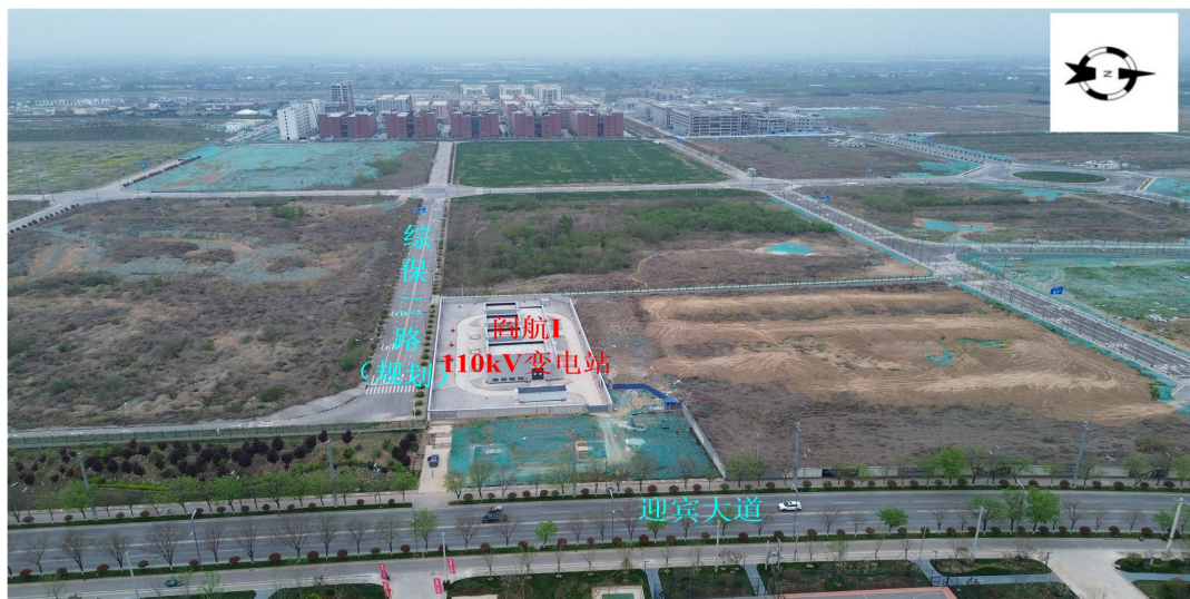
图 2-2 变电站站址现状照片（航拍）
