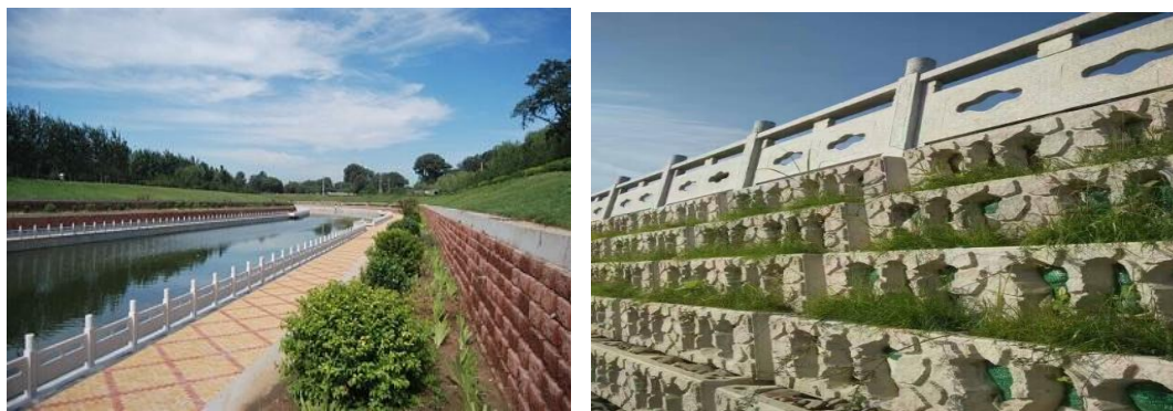
图3.2-3 生态混凝土块类挡墙
