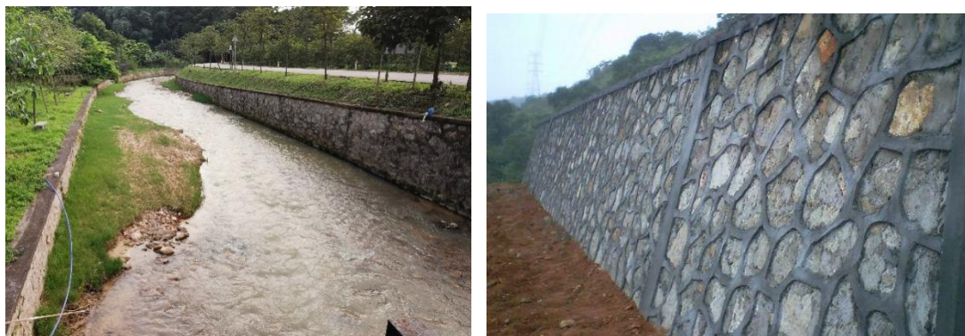
图3.2-1浆砌石挡墙型式
