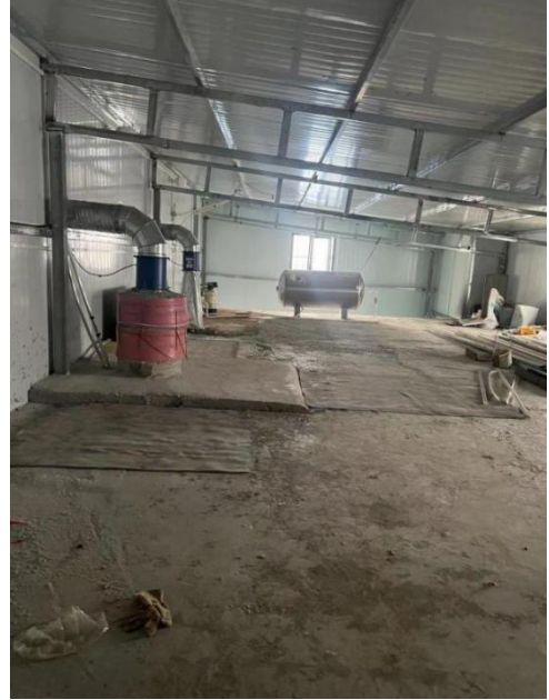
探伤室顶部二层空置区域
