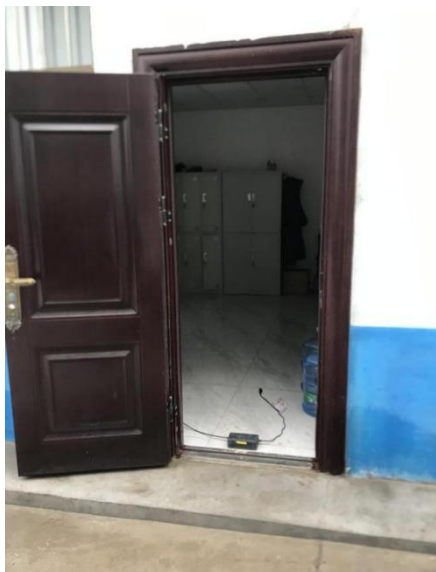
拟建危废贮存库内部
