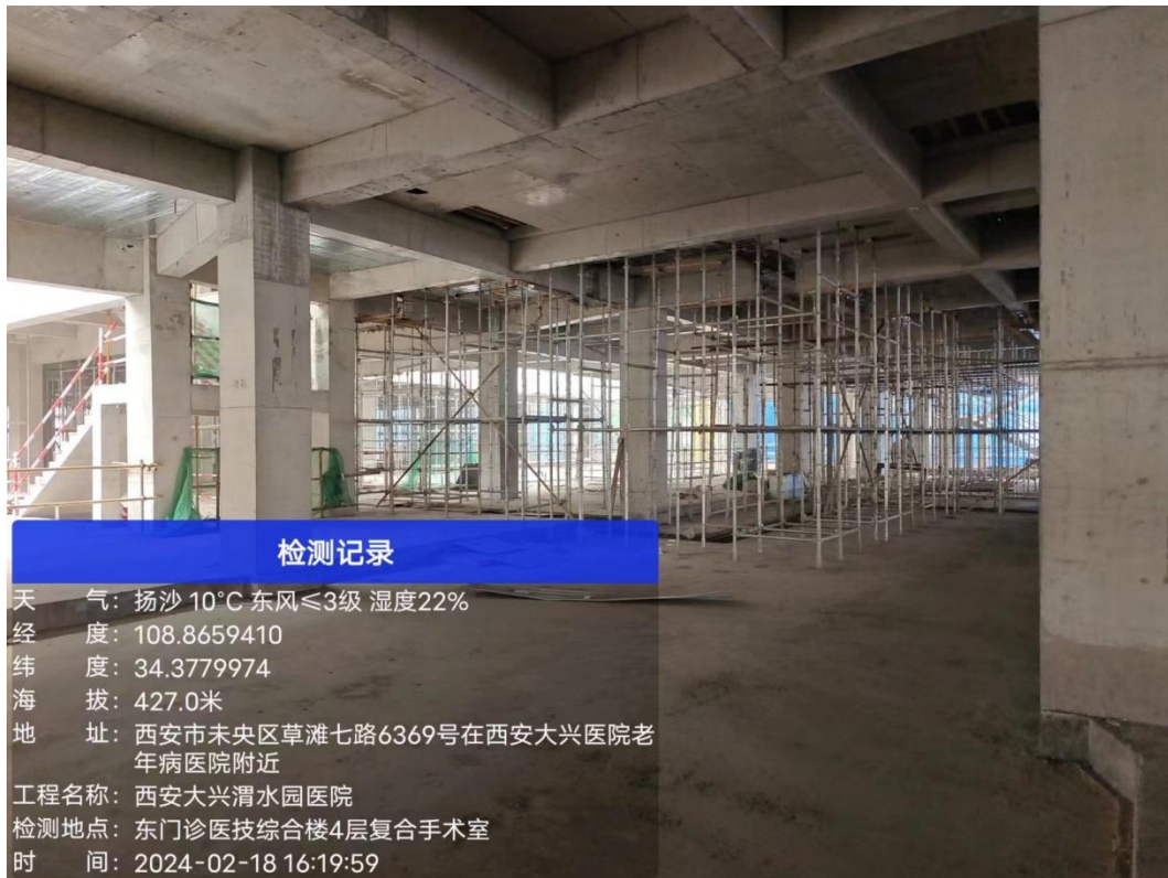
图 8-3 东门诊医技综合楼四层复合手术室场地
