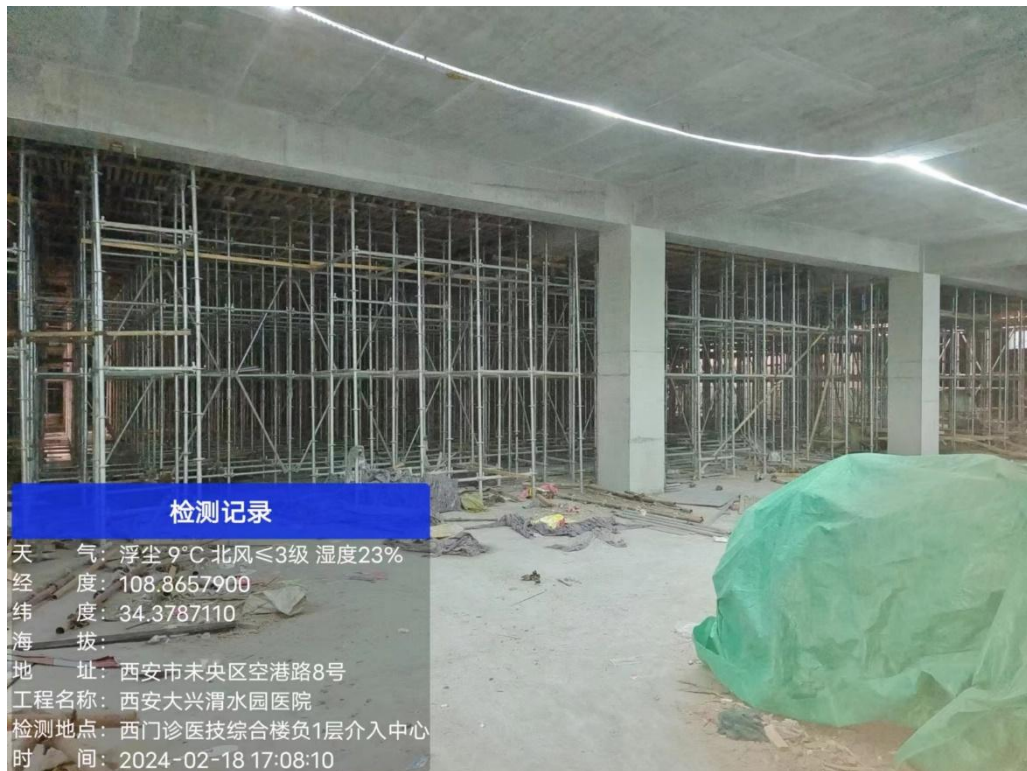
图 8-1 西门诊医技综合楼负一层介入中心场地
