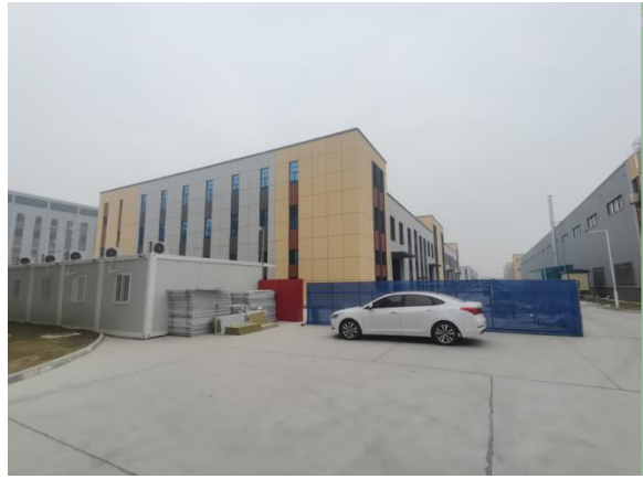
在建标准化厂房 31 座 (项目东侧)
