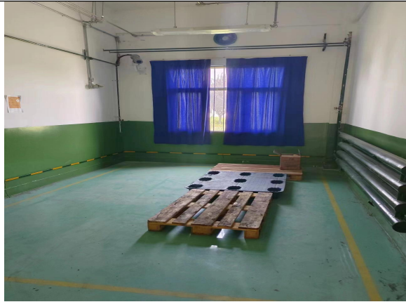
危废贮存库防渗
