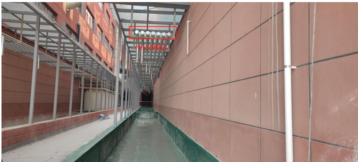
图 3.1-9 污水收集管道（园区实拍图）
