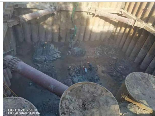
土方覆盖及桥墩施工
