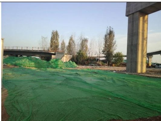
土方覆盖及桥墩施工
