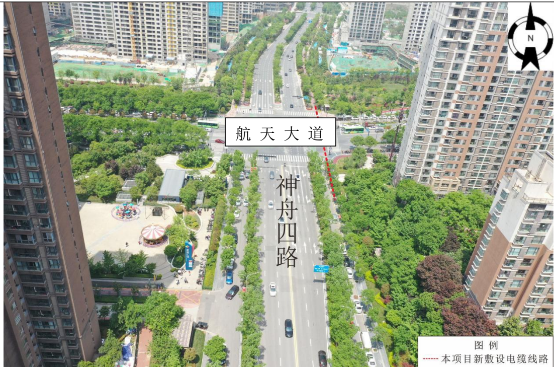
110kV电缆线路经过处（神舟四路）
