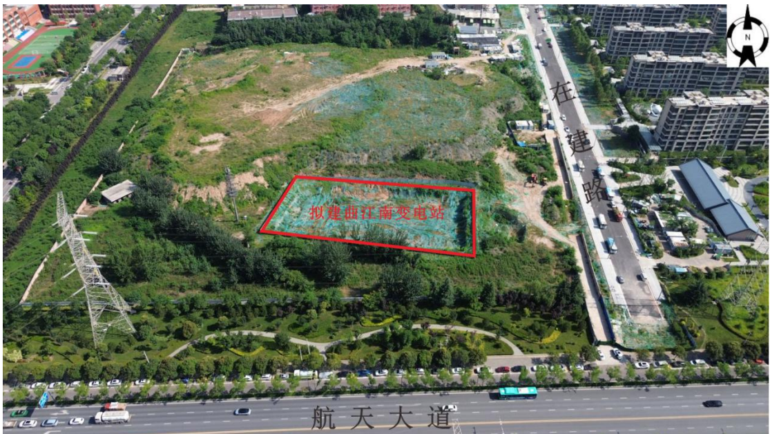
图2-3 变电站站址现状照片
