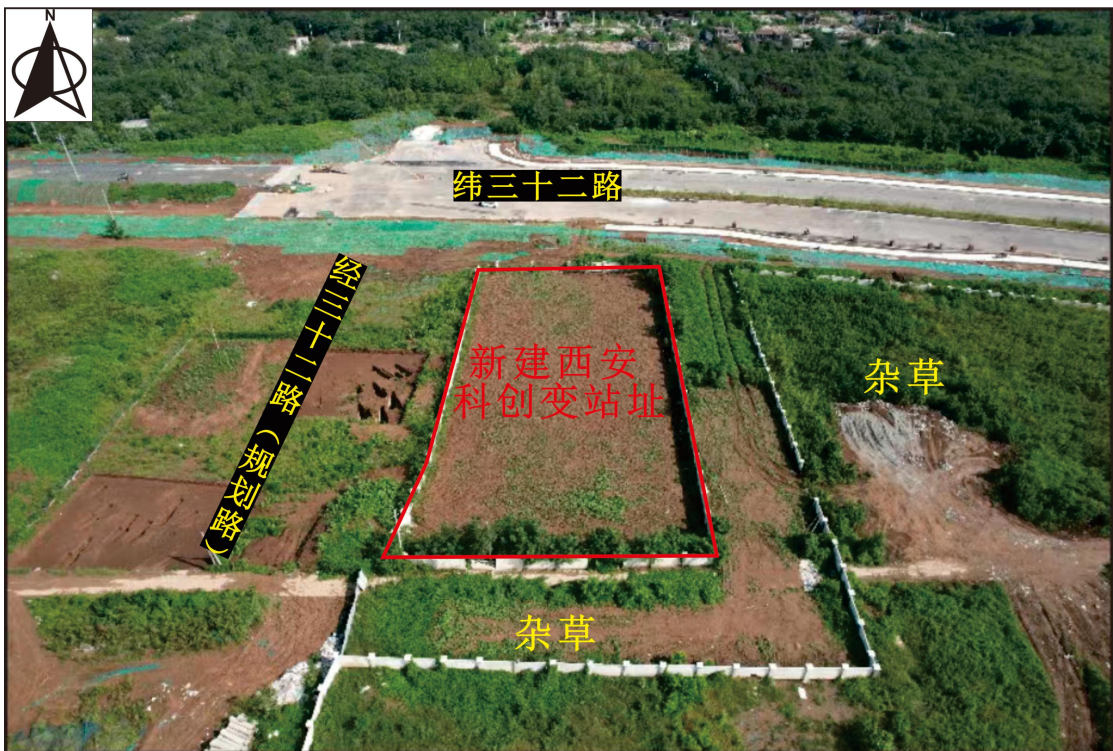
图 2-1 本项目变电站站址四邻关系现状照片
