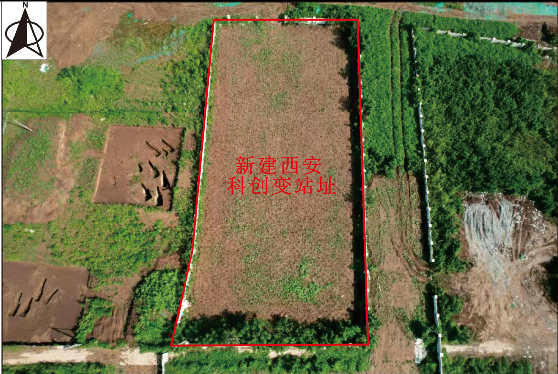
图2-3 变电站站址现状照片
