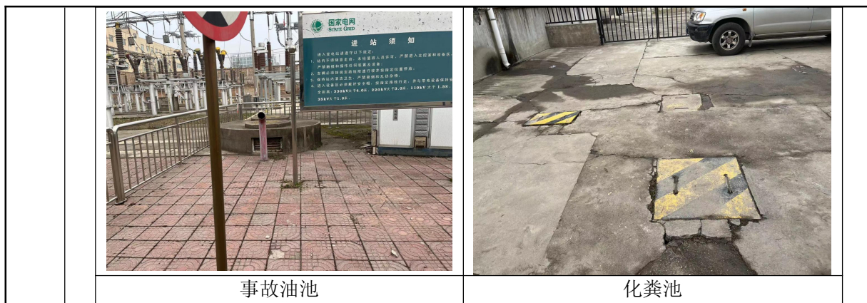
图2-3 西安110kV变电站现状照片
