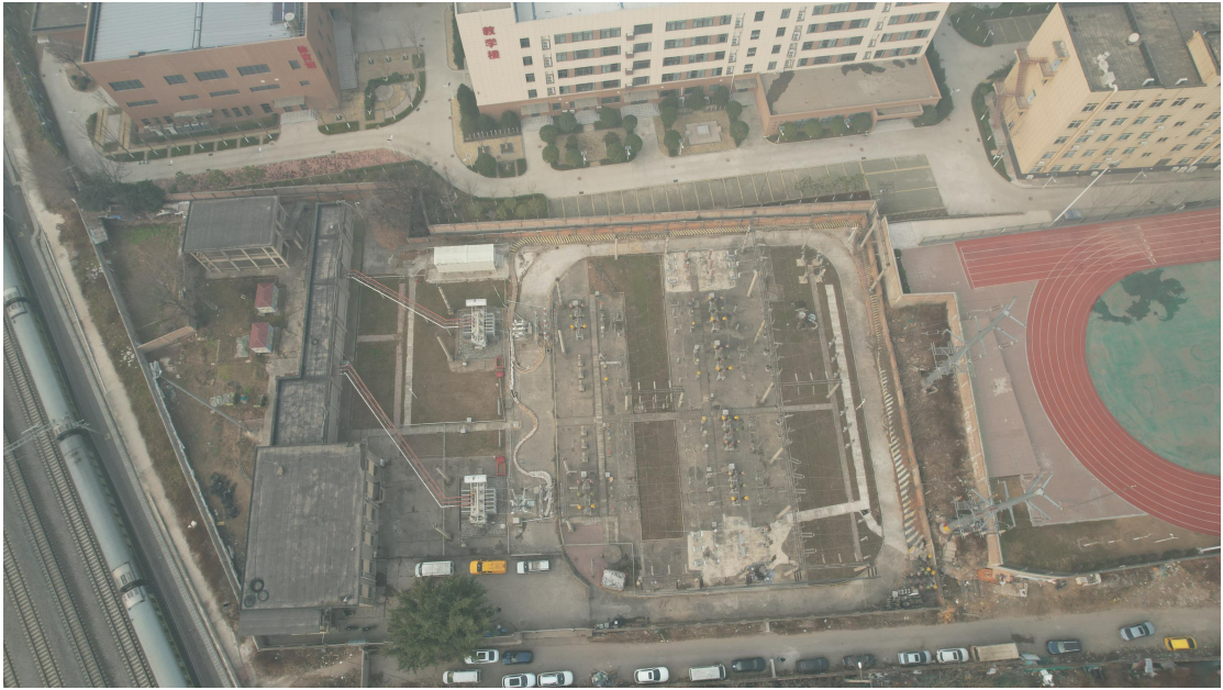
图 4-5 现有西安 110kV 变电站现状图
