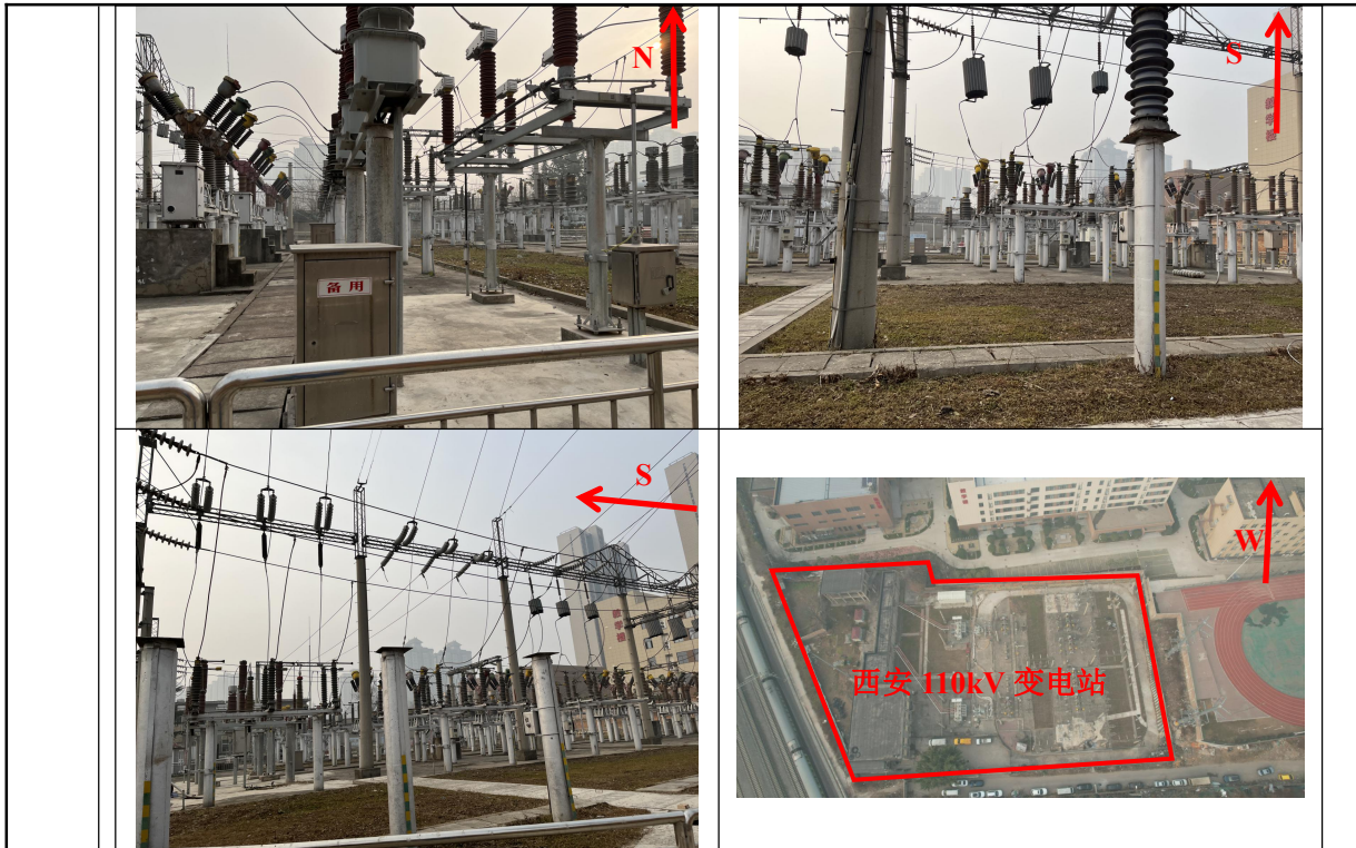
图2-4 变电站站址现状照片
