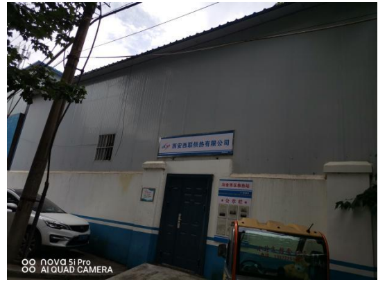
东侧供热设备机房
