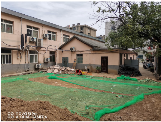
南侧拆包间及被服发放间
