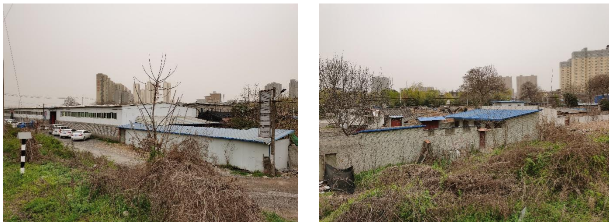
图 7 鄂邑存车场现场照片
