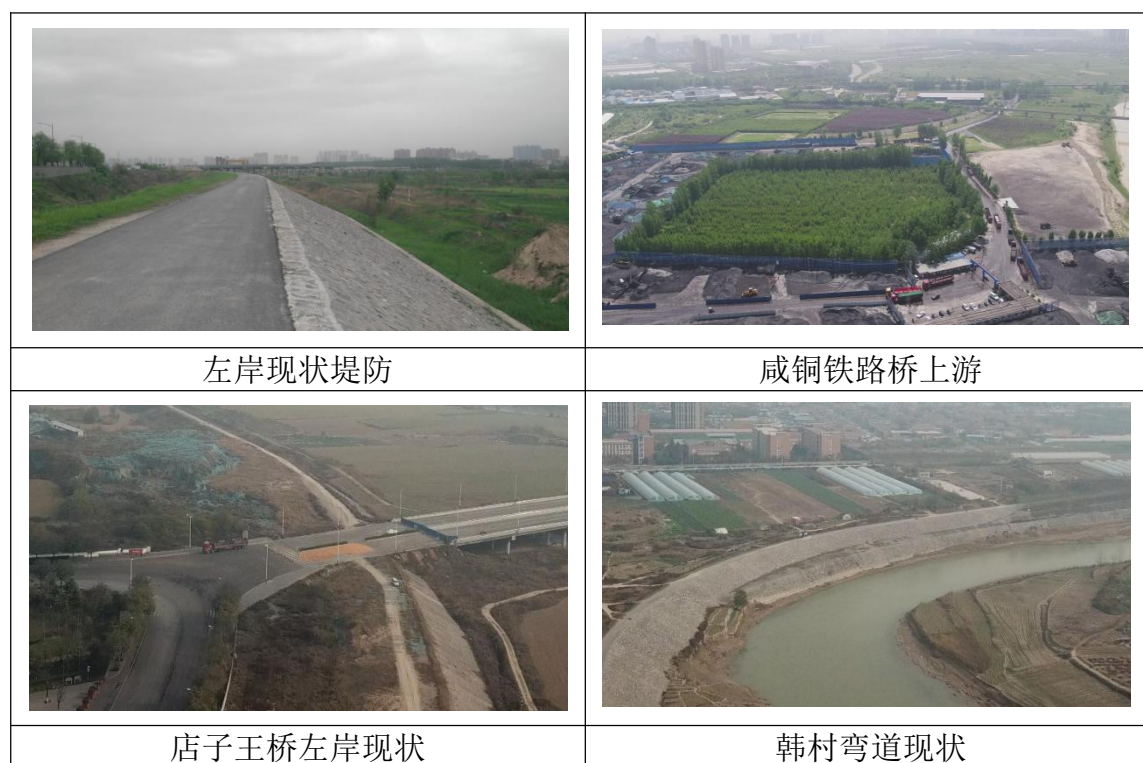
图 4.4-1 泾河治理段左岸堤防现状
