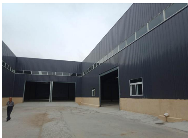
图 7-4 项目厂区地面硬化情况
