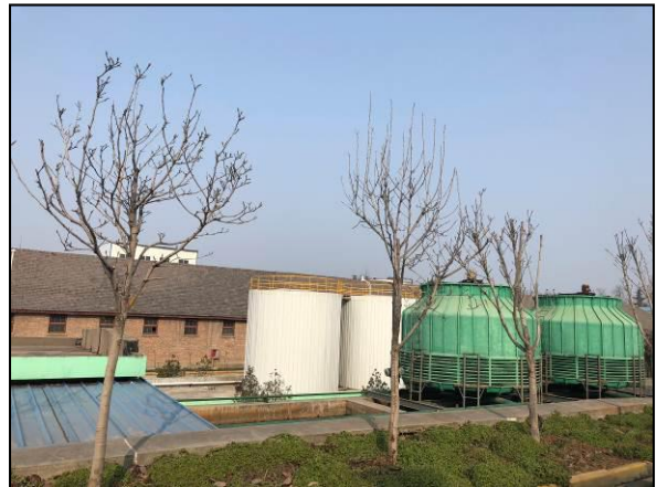
现有厂区液碱罐及冷却塔
