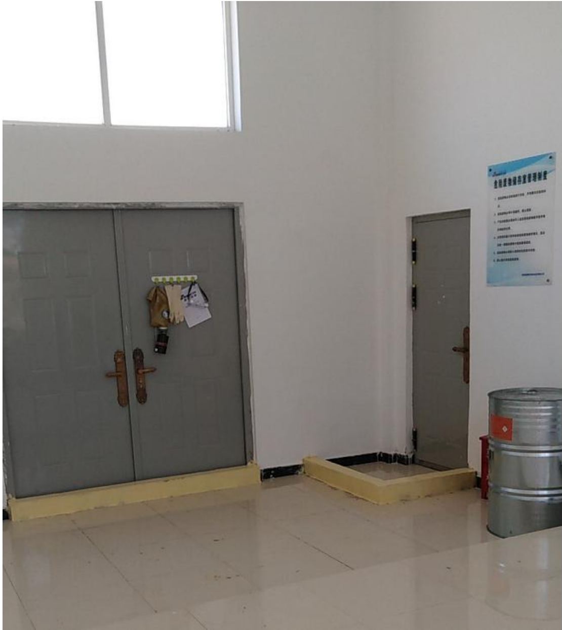
图 4.1-23 危废暂存间内部
