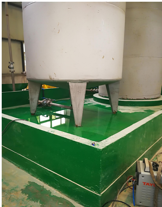
储罐区围堰
