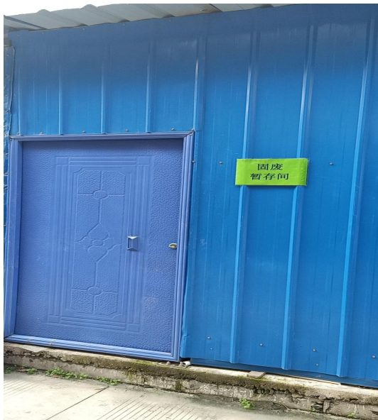
一般工业固废暂存间（外部）
