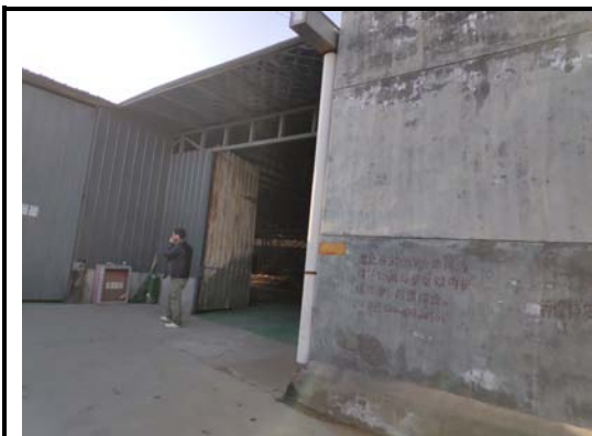
厂房外部情况（租赁）
