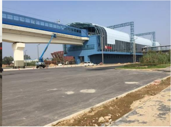
图 2.1.2.3-21 既有三号线双寨站
