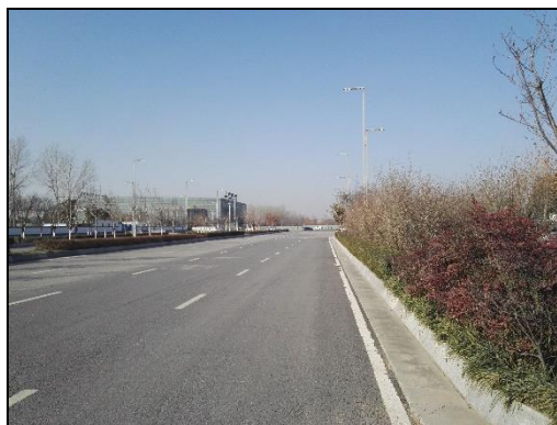
向东路道路现状（在建）
