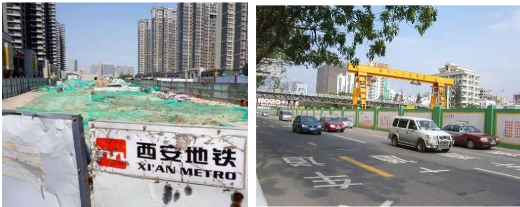
地铁施工场地
