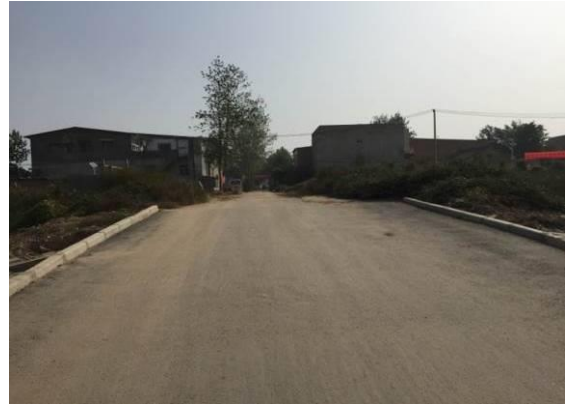
图 2.1.2.3-34 向东路东段现状
